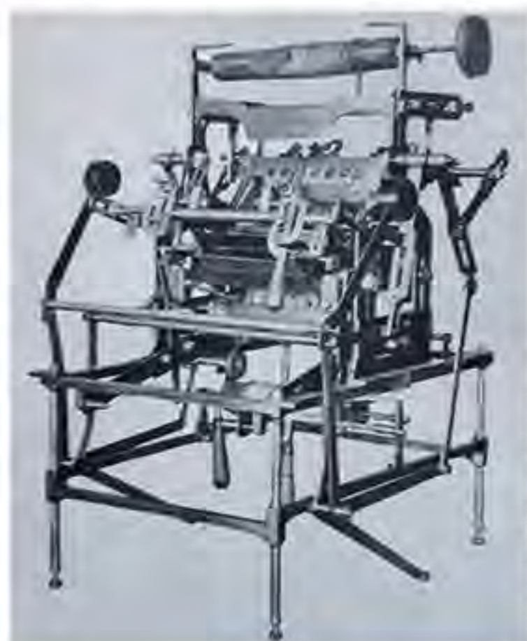
Métier Oldenborough de J. Heathcoat, 1809 17 pouces : actionné par manettes
